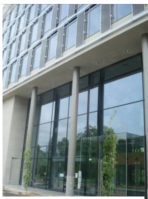
Fig 1: Aan de voorgevel vallen de monokristallijne laminaten op, die ook dienst doen als zonnewering
